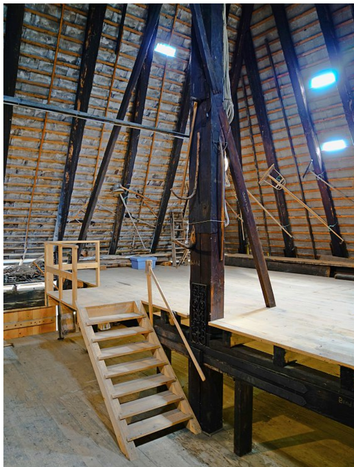
Was ein Hochstud ist, sieht man im Stallteil des Hauses.
