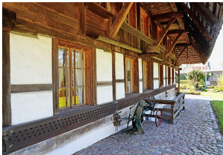
Die Würfelriese unter den Fensterbänken haben die letzten Besitzer nach alten Vorbildern rekonstruiert.
